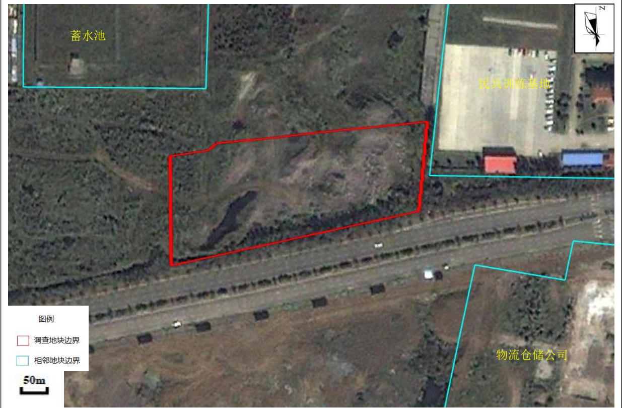
2012 年 9 月：相邻地块与 2011 年相比，东南侧物流仓储公司拆除，其余无变化。
