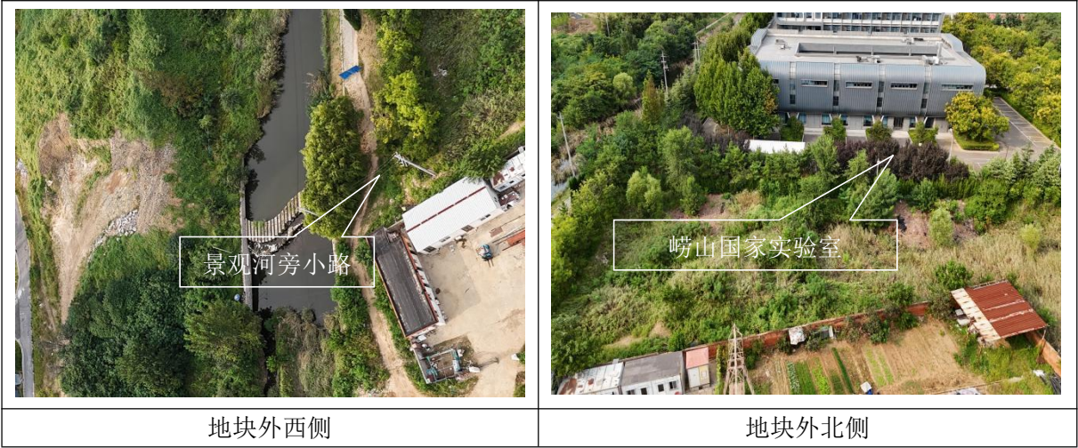
图 3.6-2 相邻地块现状照片
