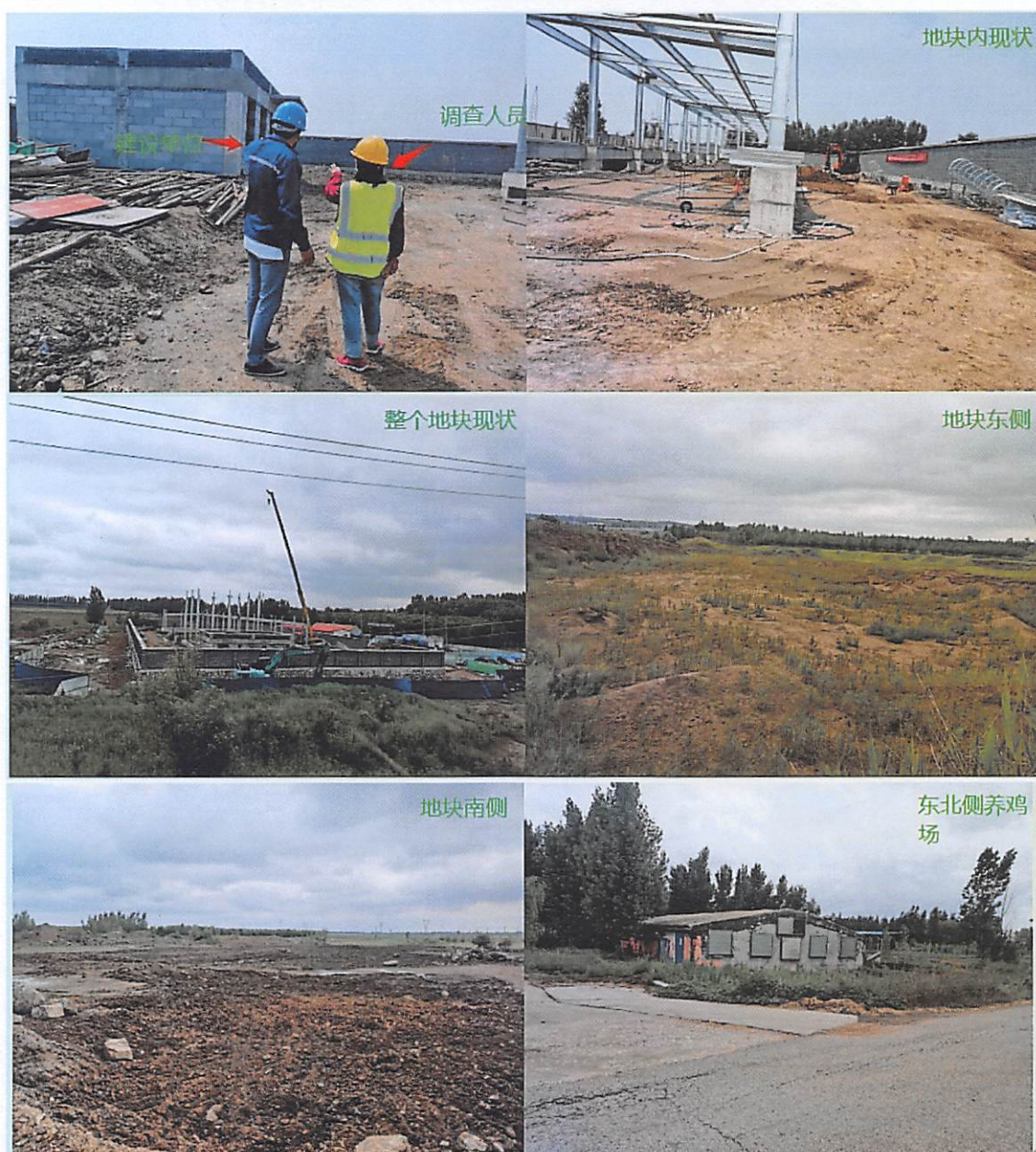
图 2.4.3 现场踏勘工作照片
