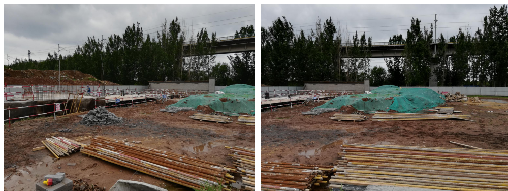
图 3.4-2 现场开挖及土堆照片
