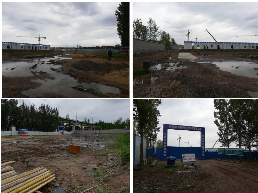
图 3.4-1 现场勘查照片
