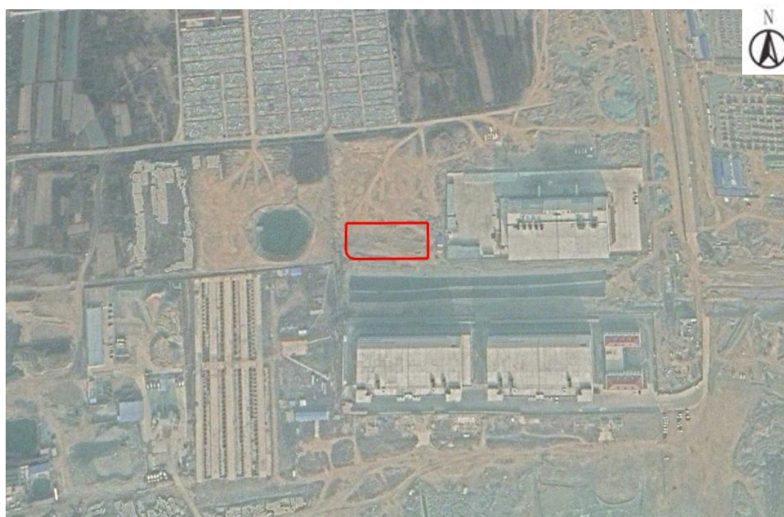
2019 年 12 月 地块周边历史：地块南侧两座冷库和地块东侧一座冷库主体框架已建设完成，配套辅助设施仍在建设中。
