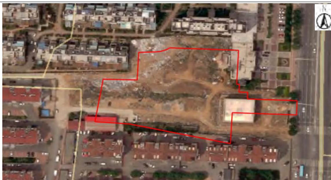
2016 年影像图：与 2014 年相比，地块内施工板房已拆除，地块闲置，为一片空地。
